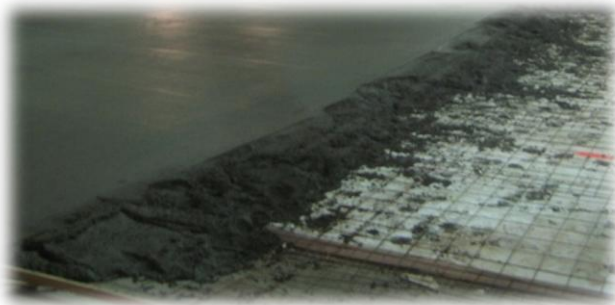
Figure 6: Ongoing Concrete Pour
